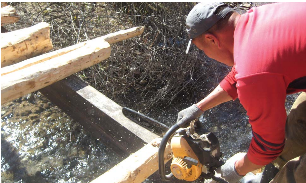
Фото 32. Восстановление моста над рекой Йри-Суу Photo 32. Repairing bridge over the river Iyri-Suu
