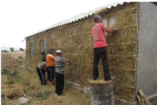
Фото 19. Мастер-класс по теплоизоляции из органич. материалов Photo 19. Master class on heat insulation with use of organic materials
