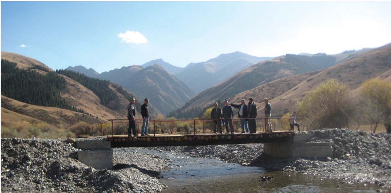
Фото 30. Мост над рекой Йри-Суу, после восстановления Photo 30. Bridge over the river Iyri-Suu, after repair
