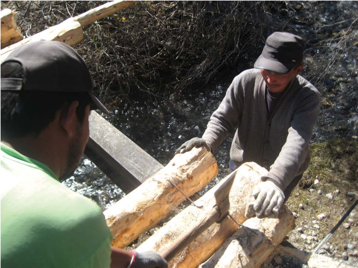
Фото 34. Восстановление моста над рекой Кичи-Чапырык Photo 34. Repairing a bridge over the river Kichi-Japyryk
