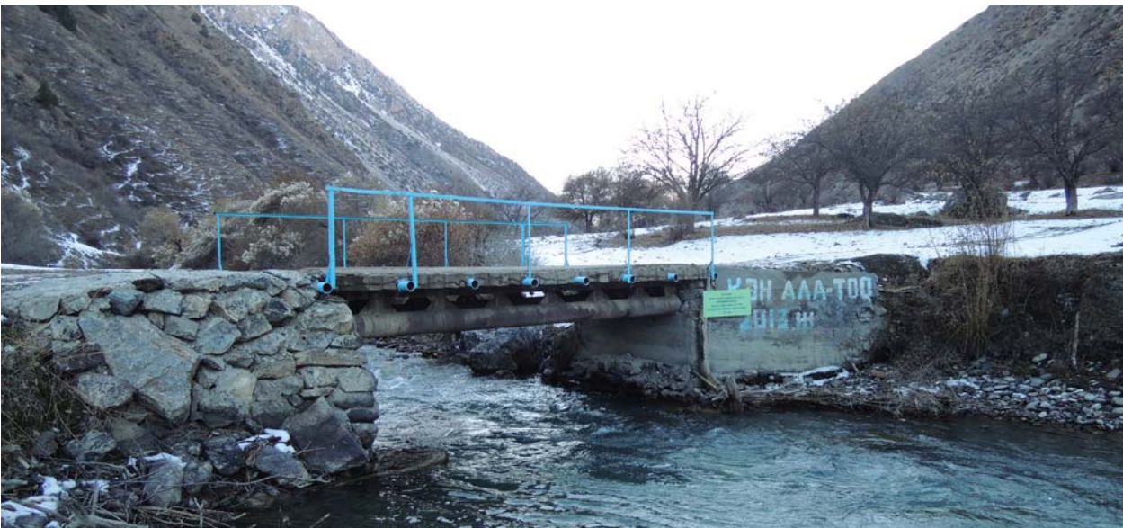
Фото 27. Построенный мост через реку Козу-Баглан Photo 27. A bridge constructed over the Kozu-Baglan river
