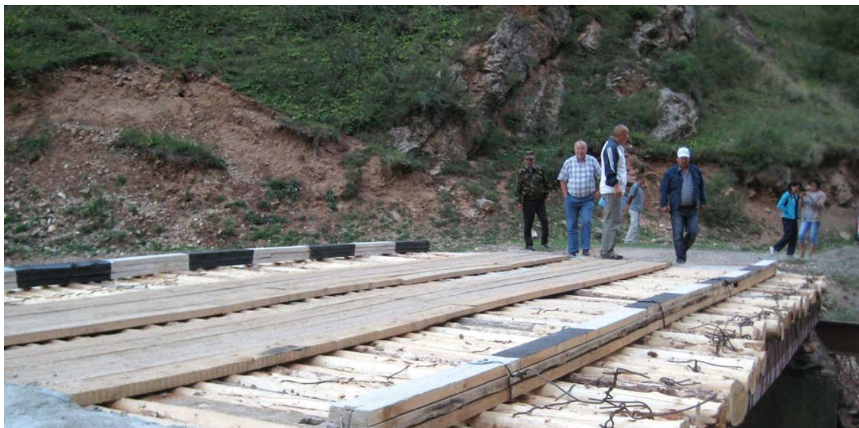
Фото 29. Мост над рекой Сон-Куль (ущ. Ит-Олгон), после восстановления Photo 29. Bridge over the river Son-Kul (It-Olgon gorge), after repair
