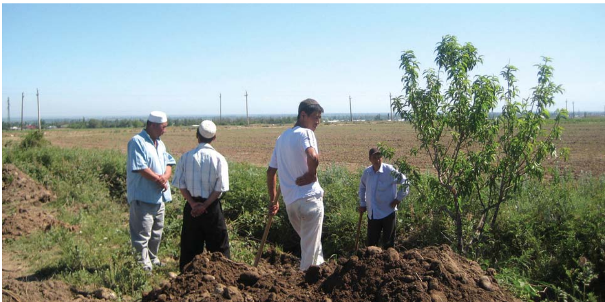
Фото 14. Сокулукский водный бассейн. Чистка ирригационных каналов. Photo 14. Sokuluk water basin. Cleaning of irrigation canals.
